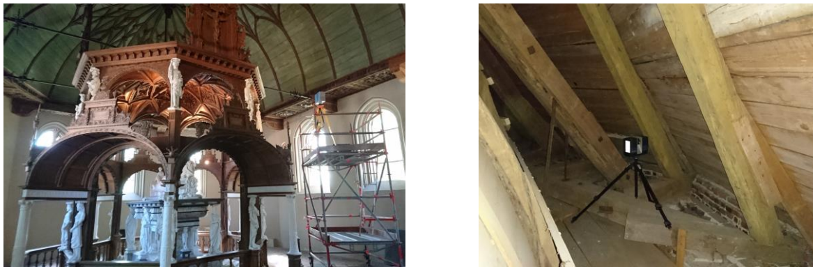
Abb. 3.1.10-2: Aufmaß des gesamten Bauwerkes mit 3D-Laserscanning.
